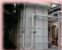
沉澱池變更 為脫硝槽
