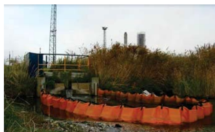
放流口處設置過濾設施
